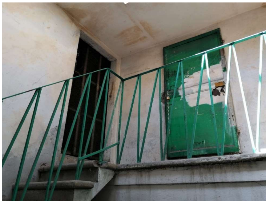
Accessi alle soffitte
