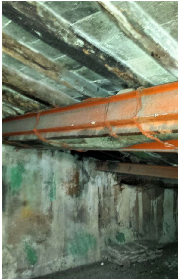
Consolidamento dei travi in copertura
