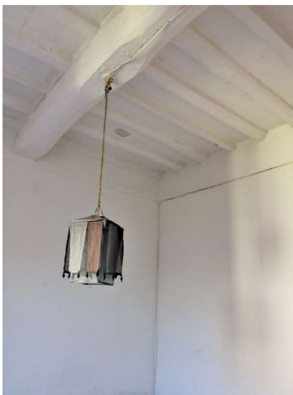
Camera da letto, solaio ligneo
